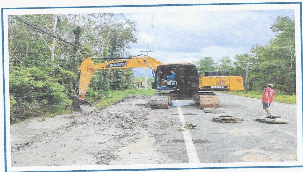
ภาพถ่ายโครงการขุดลอกลำห้วยริมถนนสายท่ามะเตือ - บางขุน (ฝั่งซ้าย - ฝั่งขวา) บ้านทุ่งรวงทอง หมู่ที่ ๑ ตำบลท่ามะเตือ ระยะทางยาว ๕,๒๕๐ เมตร หรือปริมาณดินขุดไม่น้อยกว่า ๑๑,๙๗๐ ลูกบาศก์เมตร เทศบาลตำบลบางแก้ว อำเภอบางแก้ว จังหวัดพัทลุง
