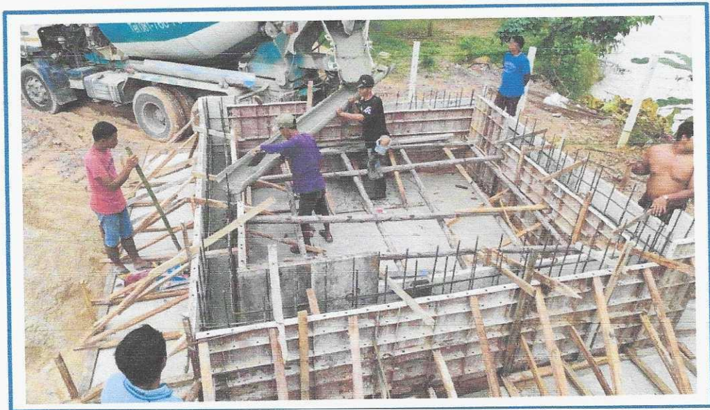
ภาพถ่ายโครงการปรับปรุงซ่อมแซมระบบประปาหมู่บ้านแบบผิวดินขนาดใหญ่มาก บ้านหุแร่ หมู่ที่ ๕ ตำบลท่ามะเตี๋ย เทศบาลตำบลบางแก้ว อำเภอบางแก้ว จังหวัดพัทลุง
